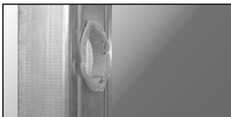
Lag et 35mm hull med f.eks. en hullstanse.
