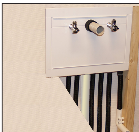
Rett montert skal fronten flukte med ferdig vegg.
