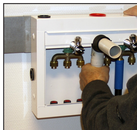
Sett inn øvre del av sprutplate og påse at gjennomføring for avløp stemmer med utsparring i plate.
