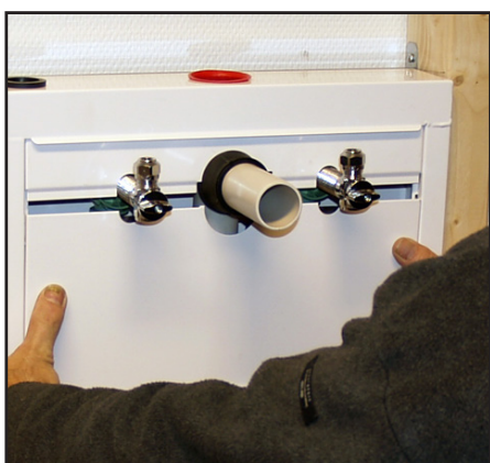
Nedre sprutplate slippes ned i skapet for så å løftes opp på fals i øvre plate. Sjekk gjennomføring.
