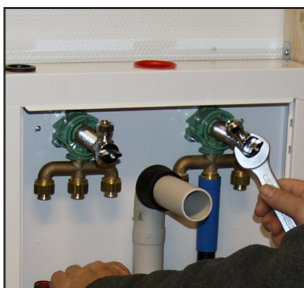
Tilpass og monter vinkelventiler i veggbokser. Plugg ubenyttede uttak.
